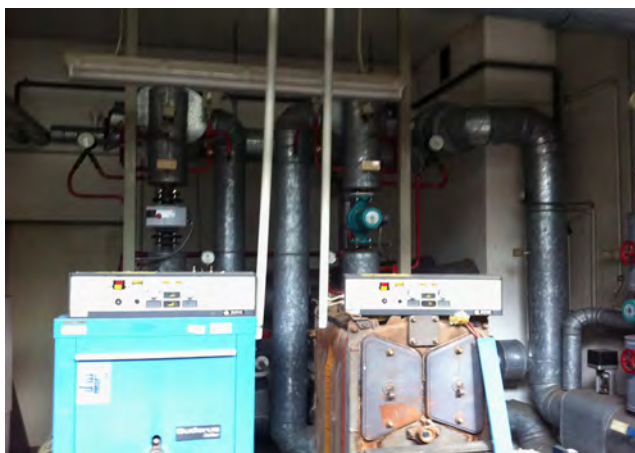
Erneuerung der Heizung / Umstellung von Gas auf Fernwärme
