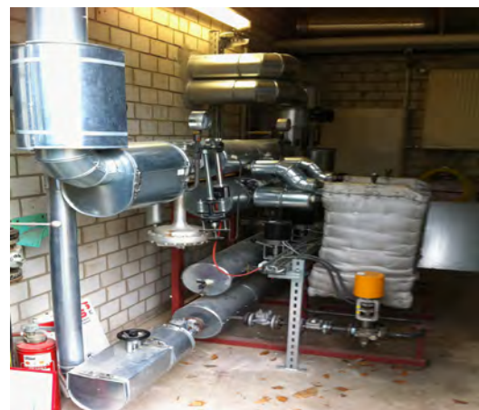
Erneuerung der Heizung / Umstellung von Gas auf Fernwärme
