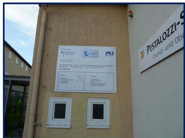
Bauschild an der Pestalozzi-Schule
