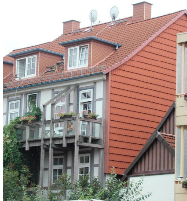
Parabolantennen lassen sich problemlos auch an den Gebäuderückseiten installieren — Beispiel aus der Neuen Marktstraße
